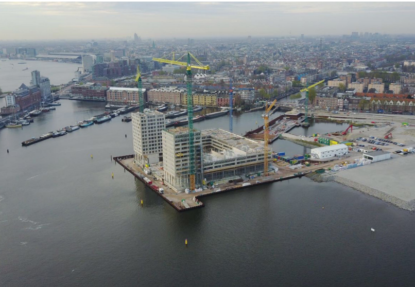
Pontsteiger in aanbouw
